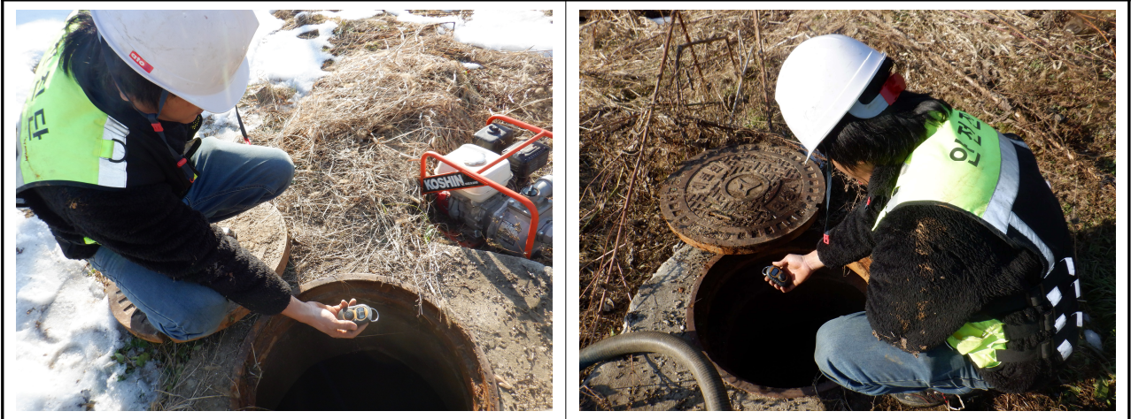
[밸브실 산소 및 유해가스 농도 측정]
